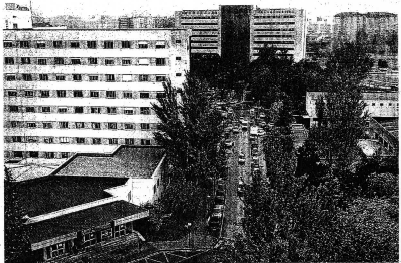
Imagen del hospital Txagorritxu, con el edificio de consultas externas al fondo. :: IGOR AIZPURY
